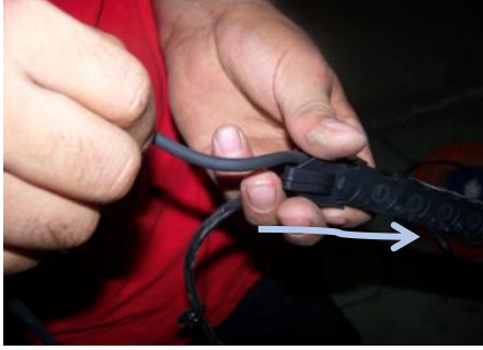
Veldo otomatik kapı opkon kablosu ana sistem tesisatına bağlanıp kablo kanalı içinden geçirilir ardından kablo kanalı işaretlenmiş yerine takılır.
